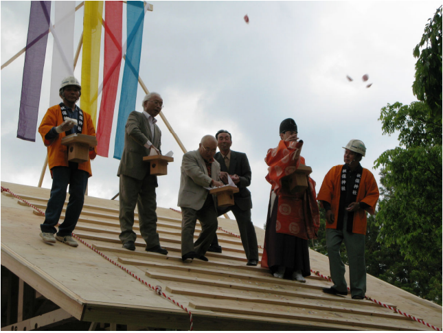
社務所別棟新築工事上棟祭 散銭散餅の儀
